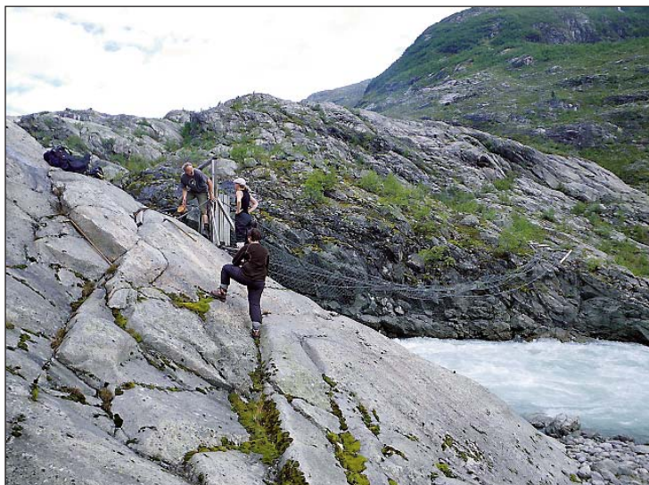
REPARASJON: Prosjektdeltakarane vil reparera denne brua for å få tilgang til området på andre sida av breelva. (Foto: Morgan Gibson)
